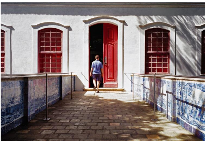
Fig. 3. Solar do Unhão's Entrance. . (Kon, N.)
